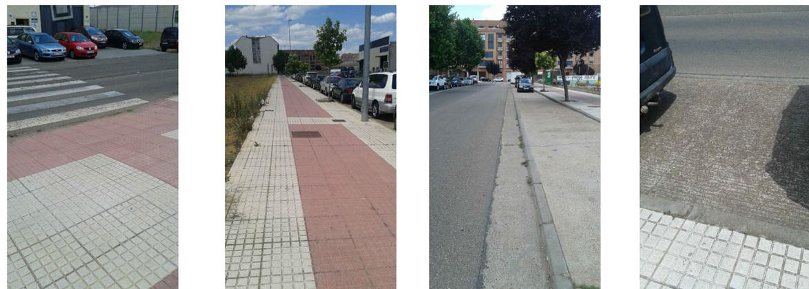
VADO PEATONAL CON PAVIMENTO TÁCTIL      BANDA PEATONAL, PAVIMENTO EN DOS TONOS      RÍGOLA HORMIGÓN CONTINUO      APARCAMIENTO HORMIGÓN RANURADO
